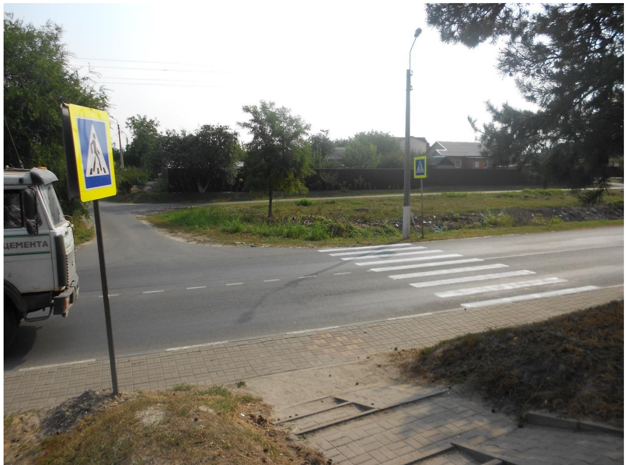
Пешеходный переход по ул. Нежегольское шоссе (район ДЮСШ №2)
