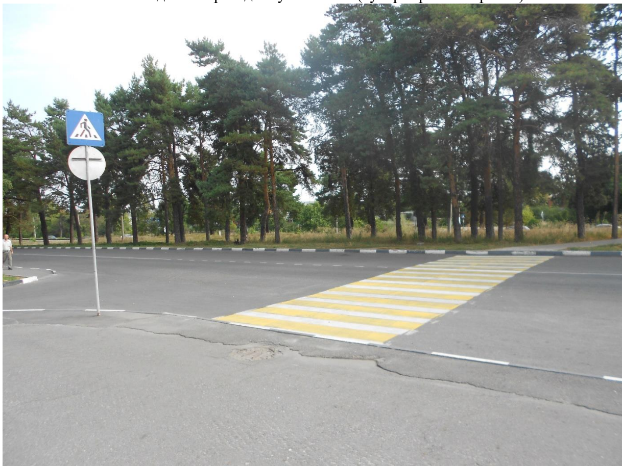
Пешеходный переход по ул. Железнодорожная (район ДЮСШ №2)
