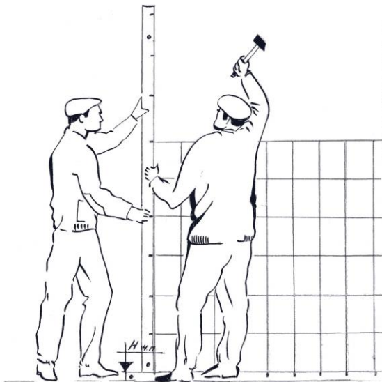
Рис. 1. Установка реек-порядовок
